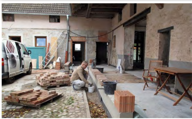
Bauarbeiten am Marienhof Foto: M. Weisheit
