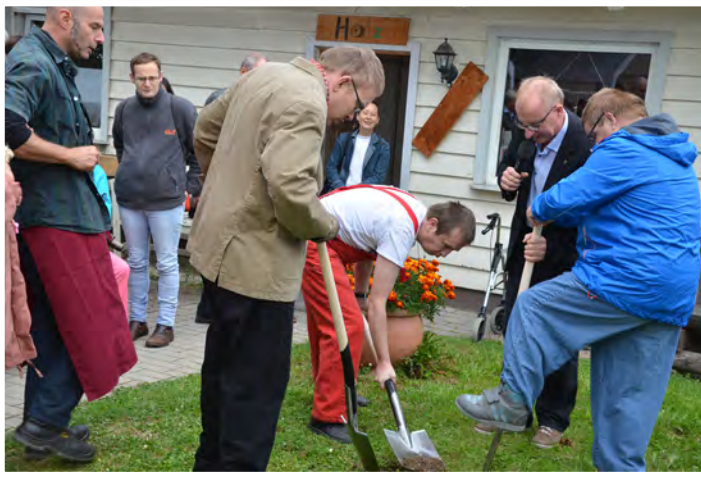
Spatenstich für die neue Tagesförderung des „Guten Hirten“ in Wernigerode Foto: I. Heilemann
