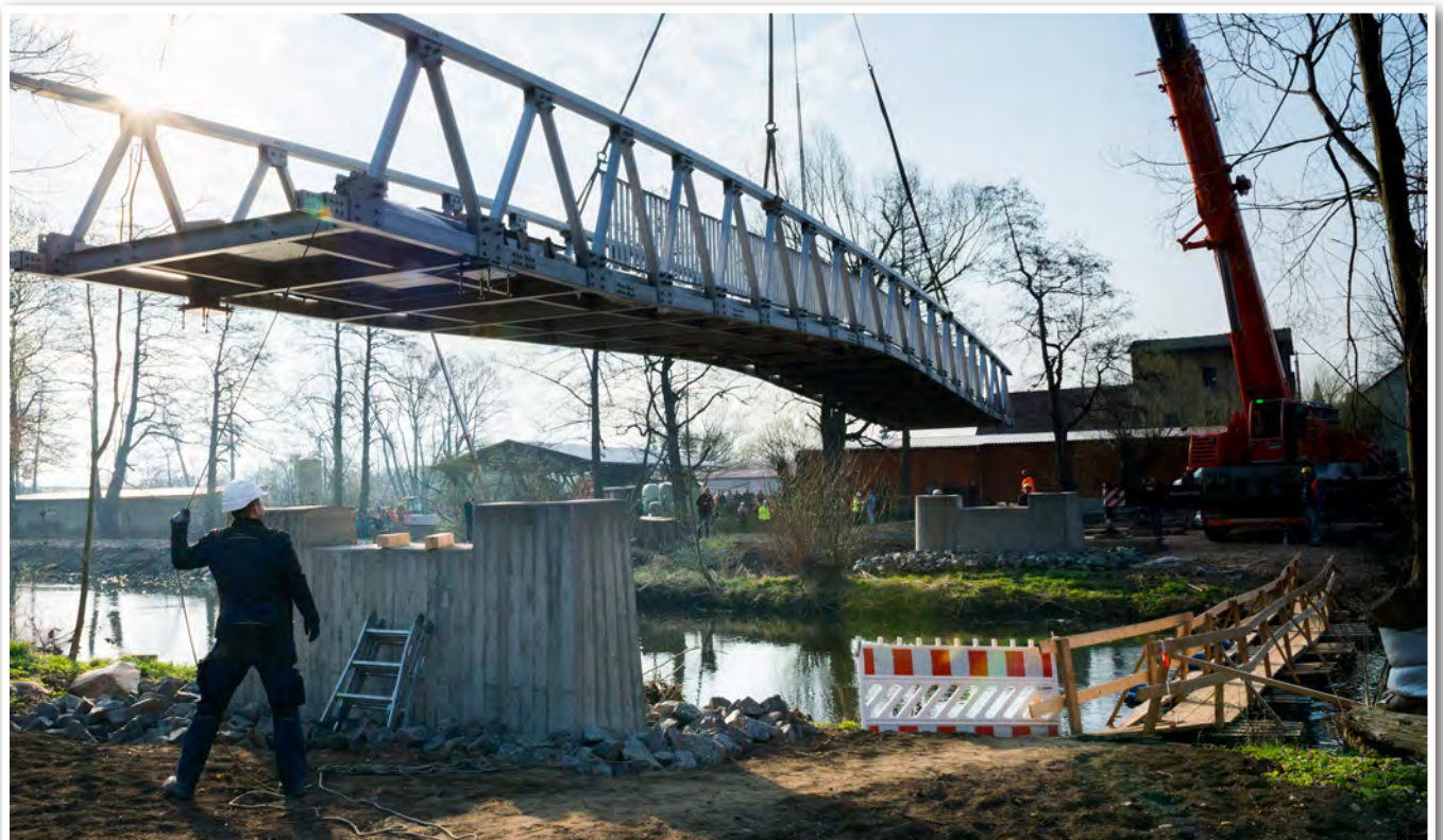
Ankunft eines Trägerelementes für die neue Brücke Foto: n'Rico Kreim
